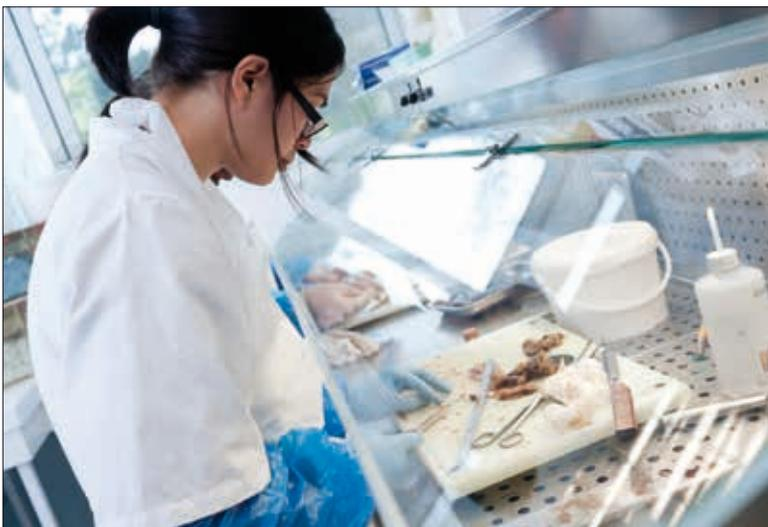
Figure 52. Les vapeurs formolées dégagées lors des observations macroscopiques sur pièces fixées sont aspirées par un système de captage enveloppant, avec aspiration en partie frontale du plan de travail.
