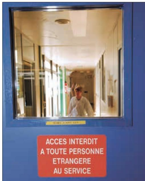
Figure 16. Portes permettant une bonne visibilité des personnes dans le laboratoire.
