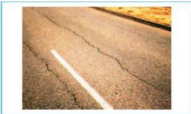
Figure 3 - Fissuration longitudinale
