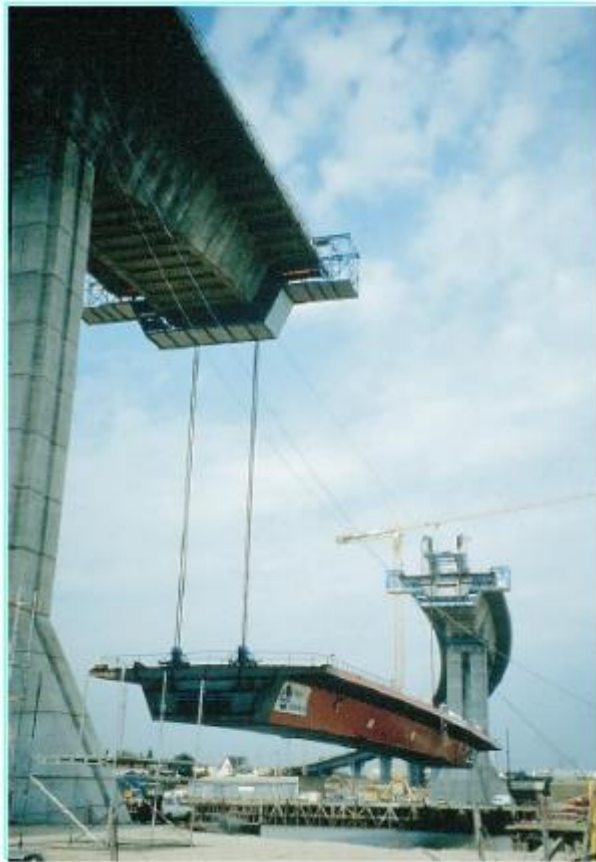
Méthodes de montage classiques du tablier d'un pont suspendu
