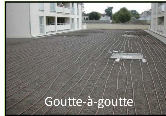
Végétation en toiture
