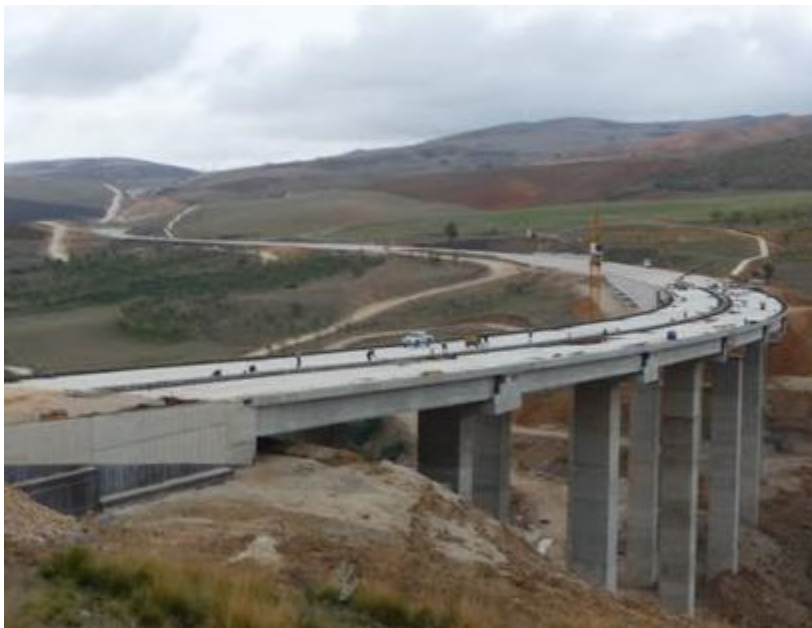
Pont sur l'autoroute Est –Ouest (Bouira)
