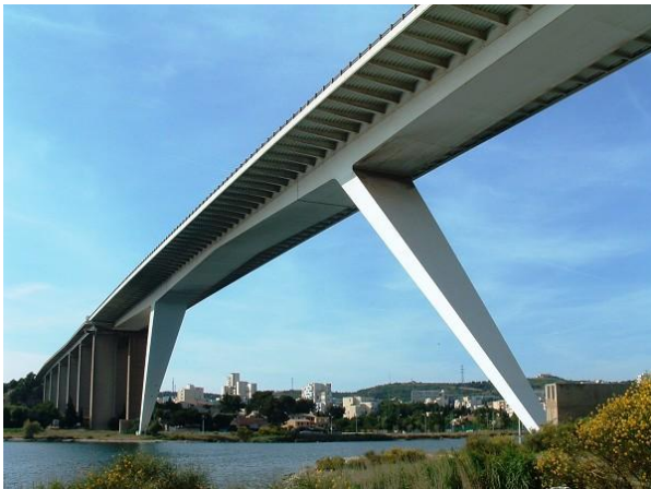
Viaduc de Martigues (France, 1972) Longueur 300m, portée principale 130m.
