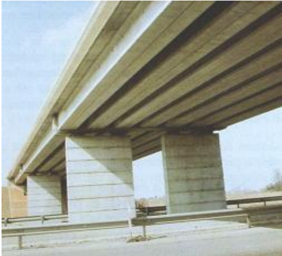
Exemple d'un pont à poutres
