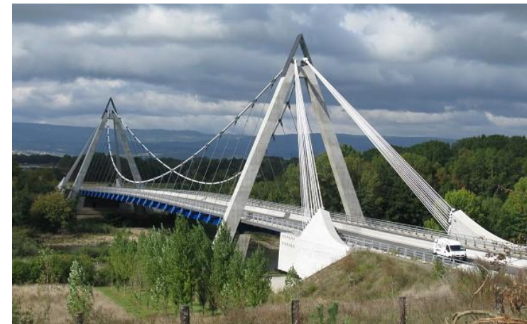
Grand pont sur la Loire (France, 2008)
