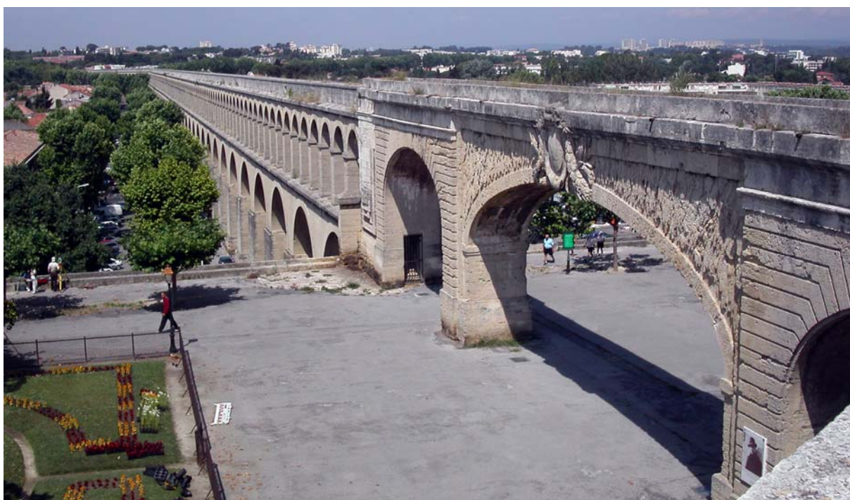
Figure 4-14 : L'aqueduc Saint Clément.
